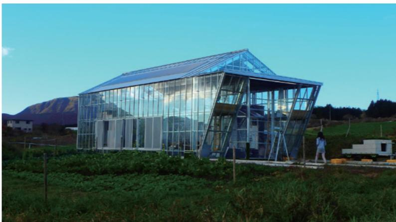
アースシップ・ラップ 屋根には2kwのソーラー発電パネルと太陽熱温水器+バッテリーでエネルギーの自給をめざす
